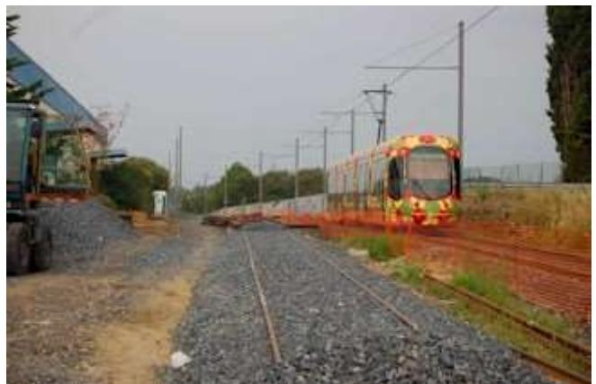
**- 19 juillet 2011** - Depuis le lundi 18 juillet 2011, et pour six semaines (lire l'info ci-dessus), de gros moyens sont engagés pour la réalisation d'une voie d'évitement du côté de la future station "Les Grisettes" à Montpellier sur la ligne 2. Une portion de voie et un aiguillage dépendant de la plate-forme propriété de Réseau Ferré de France (RFF), ont été déposés à l'ouest des "Grisettes" (photo ci-contre).
