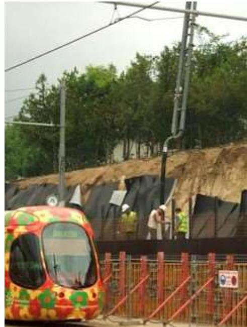
**- 7 août 2008** - Ce jeudi 7 août 2008, sur le second chantier de la ligne 2, au passage à niveau de la route de Sète, commune de Saint-Jean-de-Védas, les travaux se déroulent principalement sur la moitié de chaussée la plus proche de la station "La Condamine", c'est à dire dans le sens Montpellier-Sète. Sur l'assiette du passage à niveau, les voies sont équipées de traverses en bois avant la pose du revêtement [STRAIL](#) premium déjà réalisée sur l'autre moitié de chaussée.
