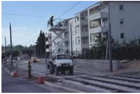
1) Intervention sur la ligne aérienne de contact, avenue Villeneuve d'Angoulême à Montpellier.
