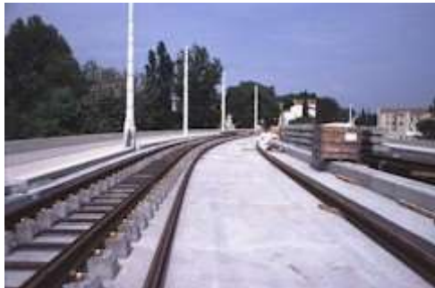
1) Pose des voies sur le nouvel ouvrage d'art construit sur le Lez raccordant Montpellier à Castelnau-le-Lez.
