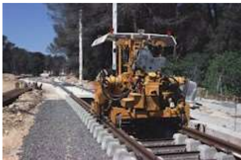
1) Bourreuse Robel de l'entreprise espagnole Vias photographiée sur le dernier coupon de voie équipé de rails Vignoles précédant le futur terminus "Jacou".
